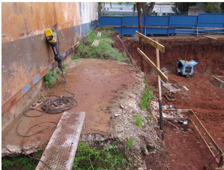
Figura 2. Sector Trinchera Piso sobre Cisterna. UE1
