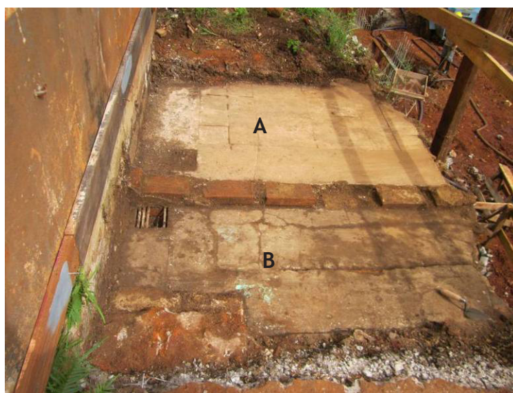
Figura 3. Sector Trinchera Piso sobre Cisterna. UE2
