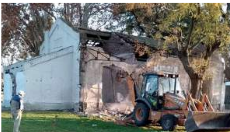
c-Estación Sorrento durante la demolición. Fuente: Vilche, 2022.
