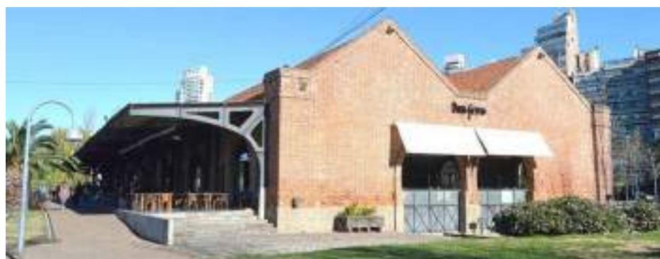
b- Estado actual del inmueble en uso gastronómico. Fuente: Fernández Priotti.
