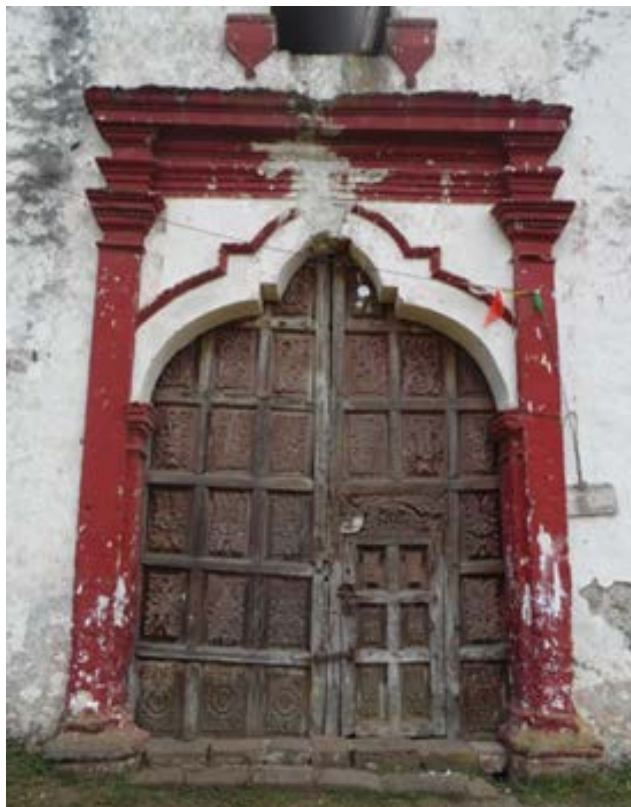
Figura 9. Puerta de acceso al templo. Fuente: G. Ramírez
