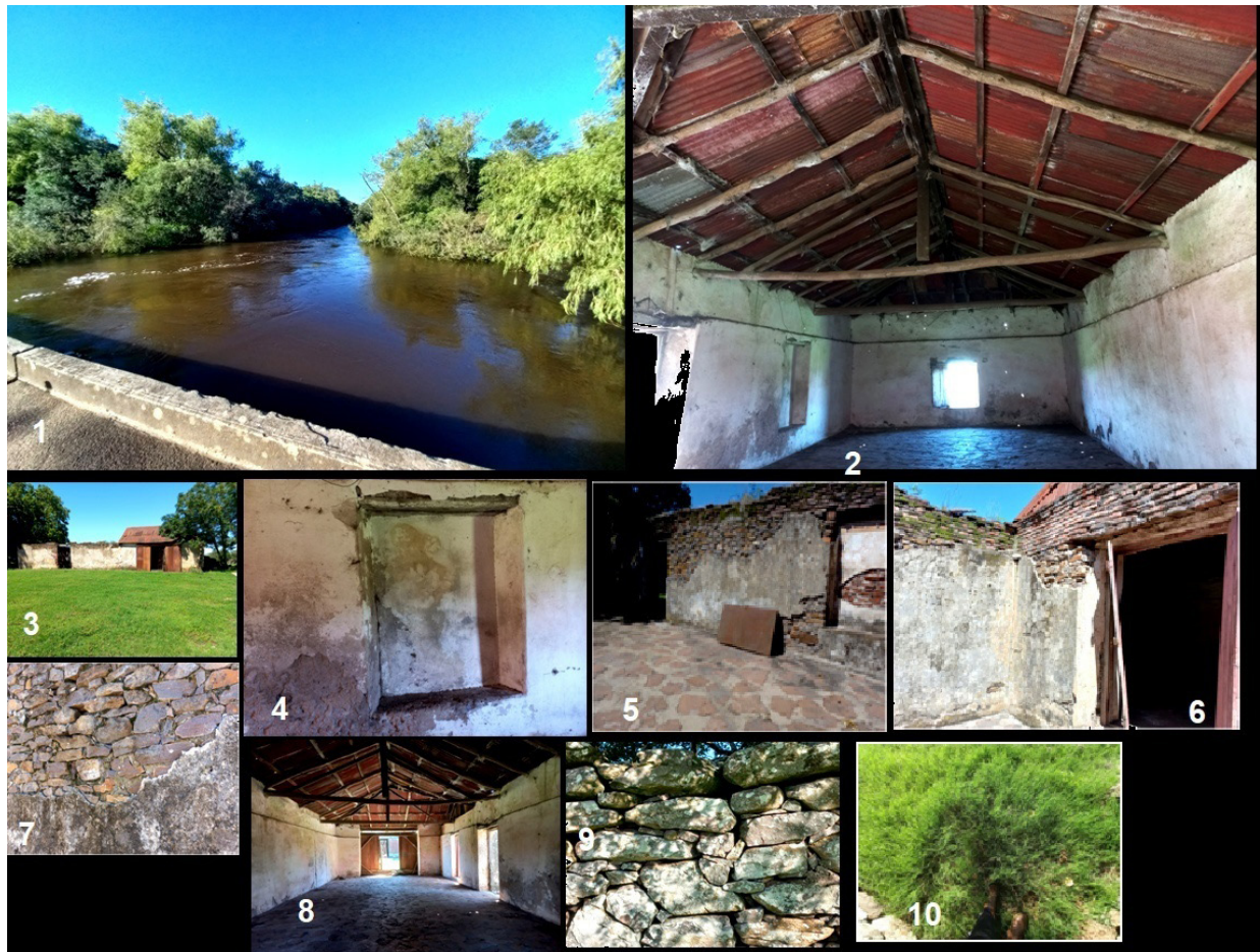
Figura 8. Casa de Rivera. Estancia Buen Retiro. Río Queguay Grande; 2. Casa de Rivera; 3. Casa de Rivera desde el oeste; 4. Hornacina en muro del Recinto A; 5. Sección de recinto B; 6. Detalle de agregado de ladrillos al mampuesto de piedra en recinto B; 7. Detalle de mampuesto, paramento interno en recinto B; 8. Vista del recinto B desde sección este; 9. Mampuesto de cerco del corral El Círculo; 10. Pastura en Estancia Buen Retiro.
