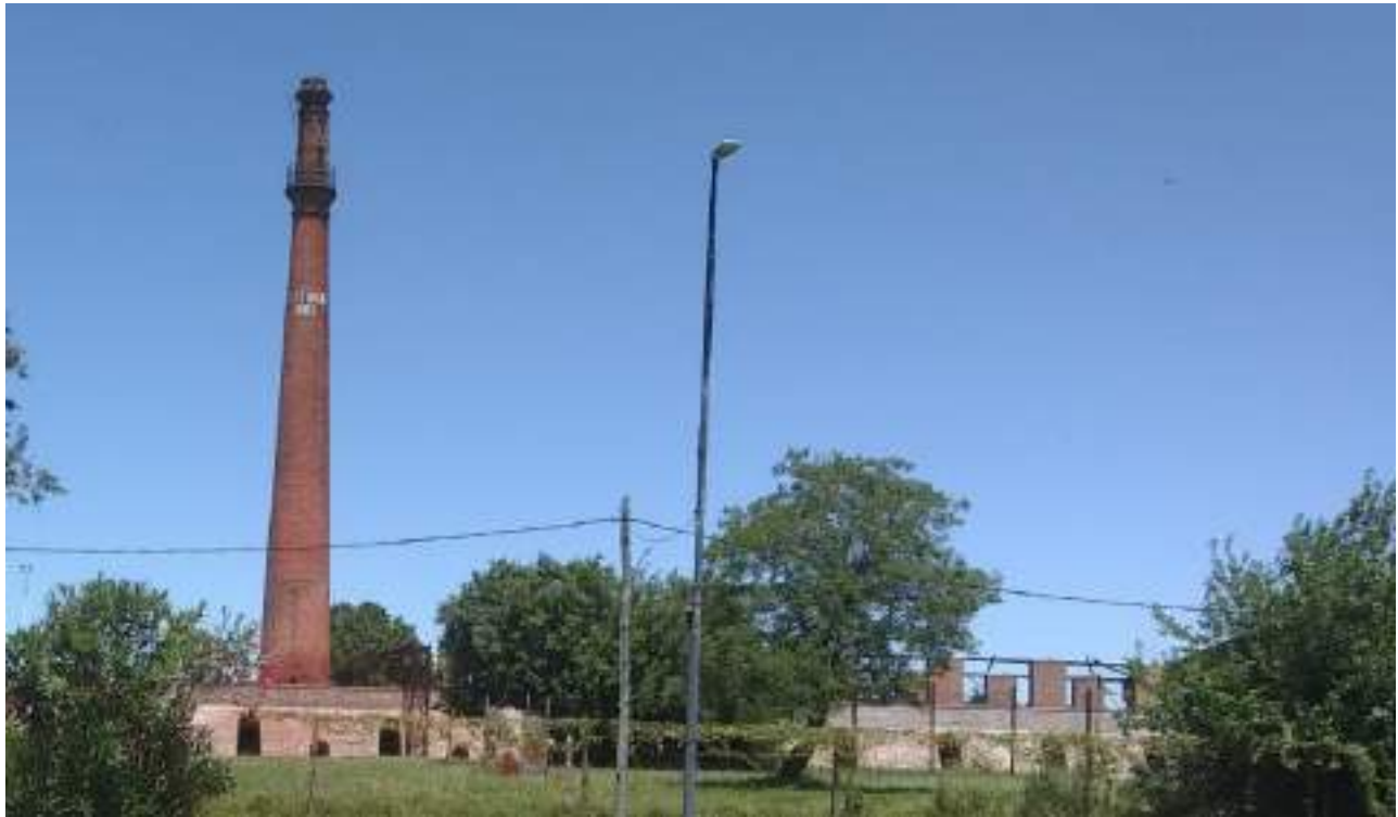
Figura 4. Chimeneas de la compañía ladrillera Ctibor actualmente en pie. En sus adyacencias se emplaza el actual Museo del Ladrillo.
