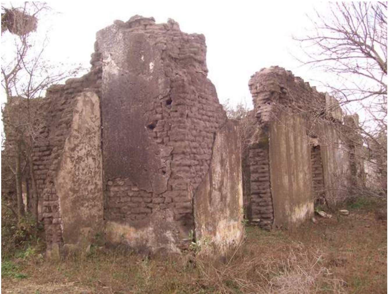
Figura 4: Edificio N°1 (vista frontis este y sur). En primer plano, contrafuerte de la pared sur.
