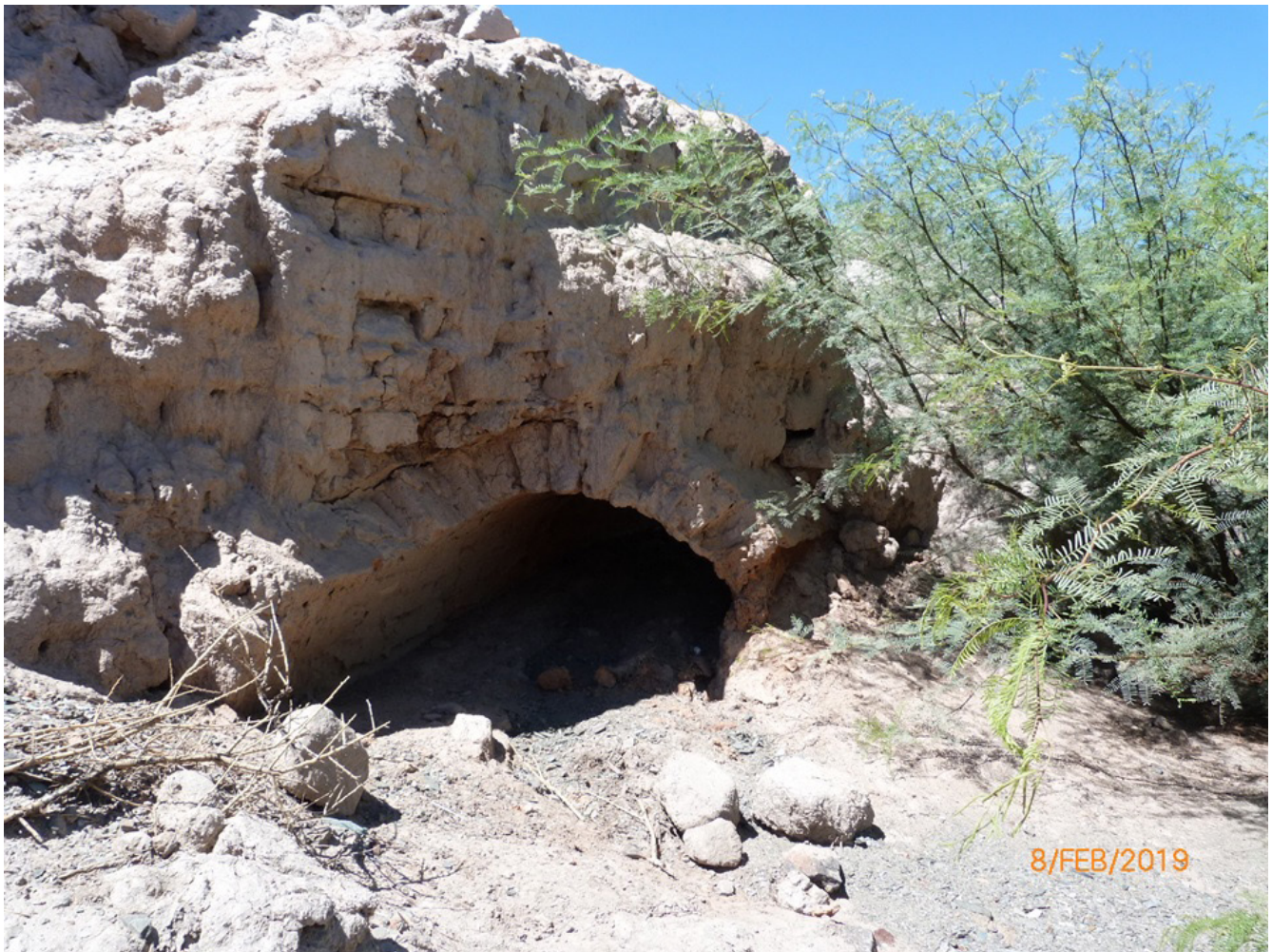
Figura 3. Boca de uno de los túneles subterráneos
