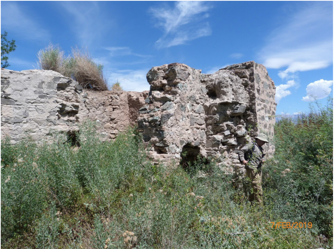
Figura 2. Basamento de la instalación hidráulica para trapiche y/o generación de energía
