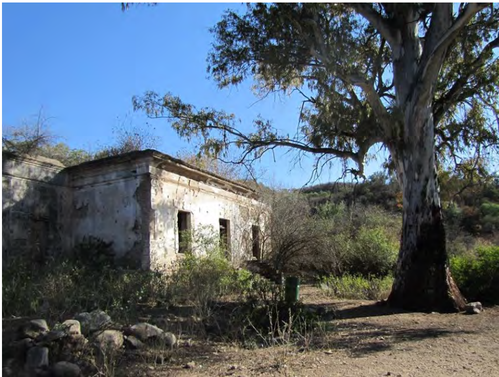
Figura 3: Vivienda del siglo XIX construida sobre las ruinas jesuitas
