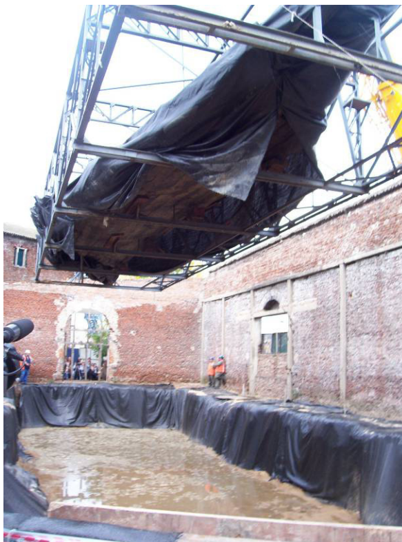
Figura 1. Proceso de re-enterramiento de la estructura naval del Pecio Zencity (ph. E. Tavella)
