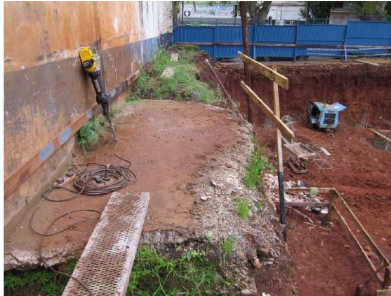
Figura 2. Sector Trinchera Piso sobre Cisterna. UE1
