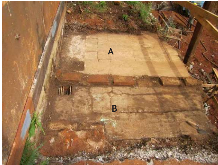
Figura 3. Sector Trinchera Piso sobre Cisterna. UE2
