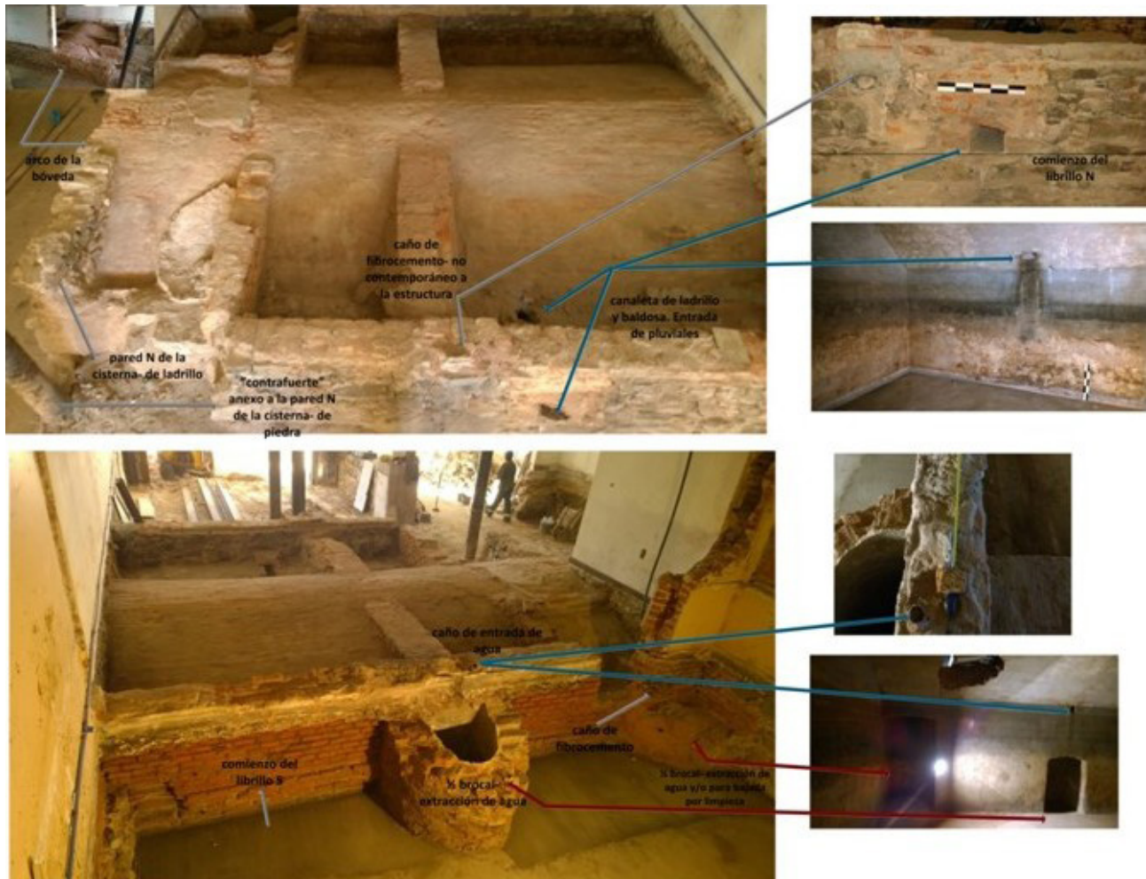
Figura 6. Vista la bóveda de la cisterna y del muro Sur con brocal. Con referencias y señalamiento a las entradas y anexos para la extracción de agua.
