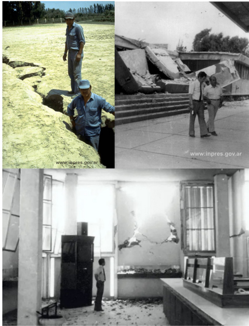
Figura 9. Imágenes de los efectos producidos en Caucete durante el terremoto de 1977: grietas de más de 0,60 m de profundidad, caída de losas producto del efecto columna corta y grietas en paredes a 45°. Fuente: Biblioteca INPRES.
