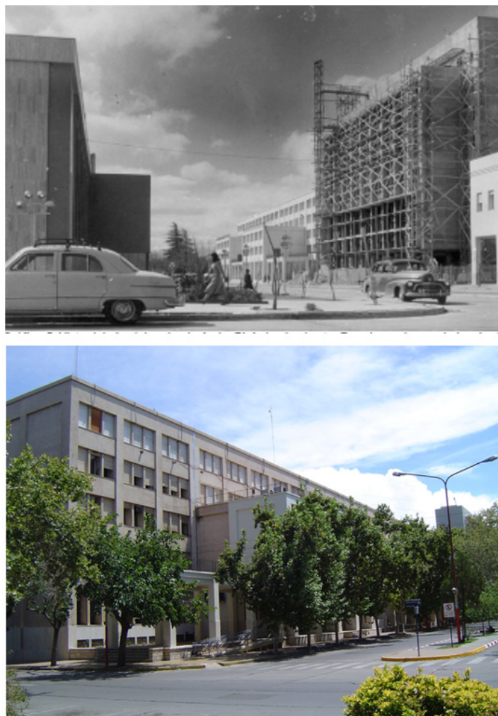
Figura 10. Imágenes de la avenida Central durante su construcción en donde se observa el ex Banco Hipotecario Argentino a la derecha (hoy Rectorado de la UNSJ) y Edificio 9 de Julio en la actualidad.
