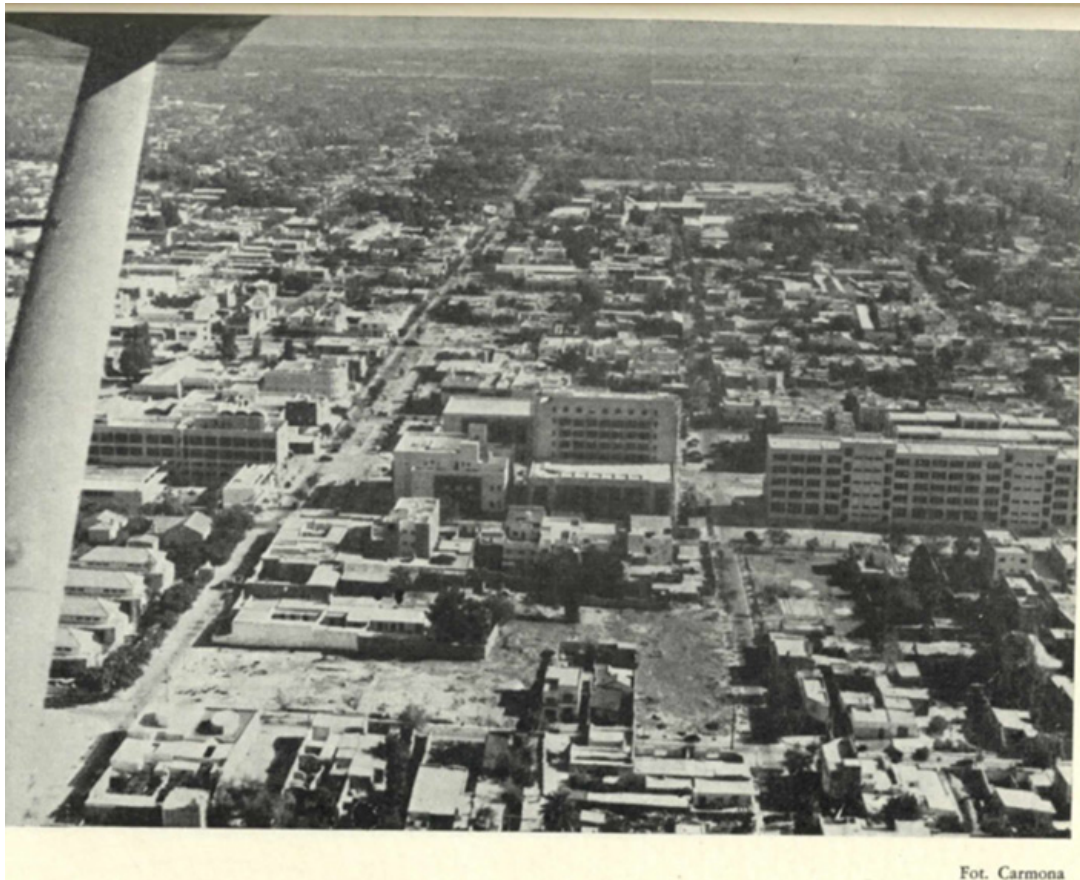
Figura 8. Fotografía aérea de la ciudad de San Juan, donde se observan varios de los edificios construidos sobre la Avenida Central: Banco Hipotecario Nacional, Rectorado de la UNSJ y el Edificio 9 de Julio. Fuente: Carmona.
