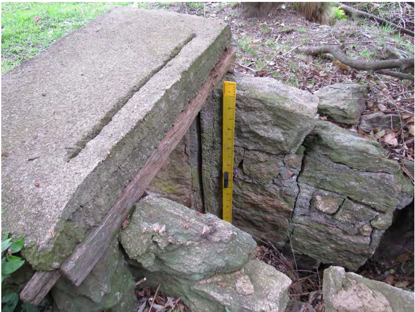
Figura 7. Toma de agua, acequia de la margen derecha.
