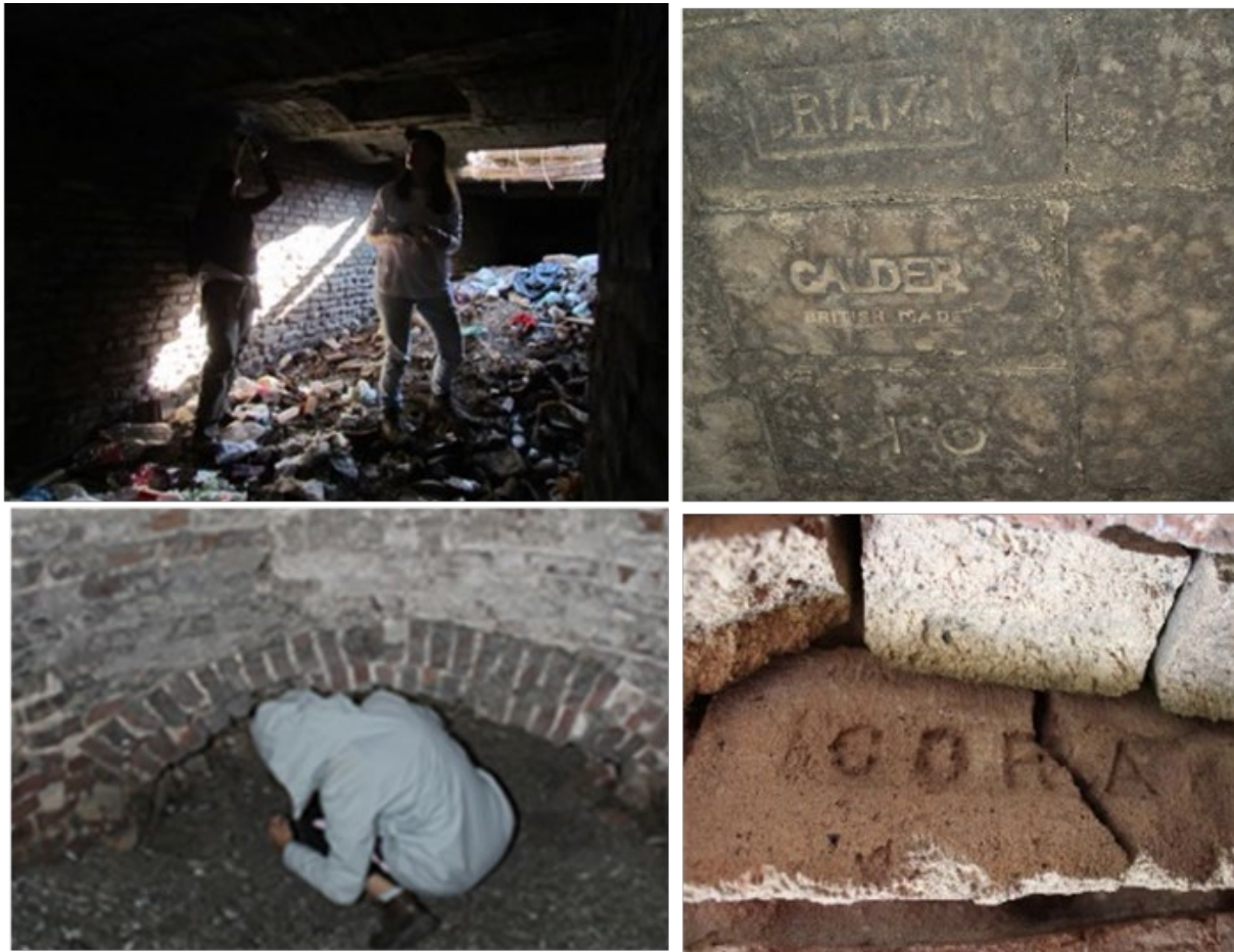
Figura 8. Identificación de ladrillos refractarios in situ: imagen superior, túnel que comunicaba sector caldera con chimenea en La Gallareta; imagen inferior, túnel clausurado en Villa Ana.
