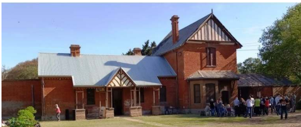
b-Estado actual Estación Antártida Argentina en servicio de pasajeros y otros usos. Fuente: R. Maggi
