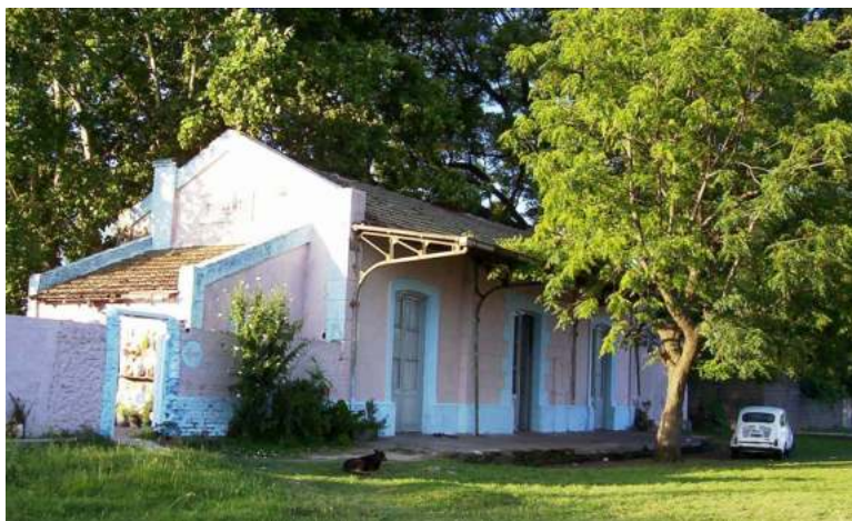
b-Estación Sorrento antes de la demolición. Fuente: R. Maggi.
