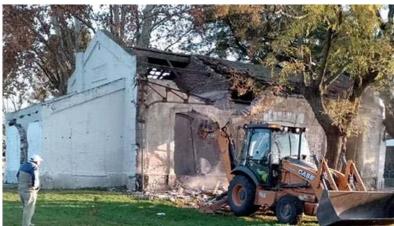
c-Estación Sorrento durante la demolición. Fuente: Vilche, 2022.
