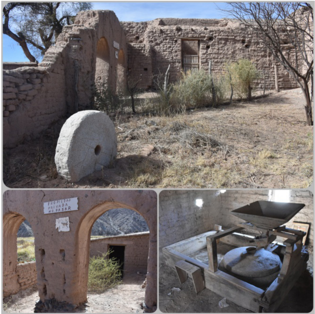
Figura 3. Sup.: habitaciones que integran el Molino Harinero de Payogasta. Inf. Izq.: arcos estilo colonial e ingreso a la habitación de molienda. Inf. Der.: maquinaria de molienda. Fotos del Lic. Andrés Jakel y el Lic. Pablo Pifano.
