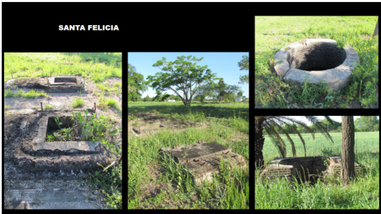
Figura 4. Fundaciones en sector sala de máquinas (Izq.) y bases de chimeneas (Der.). Fotografías: Pedro Sánchez.
