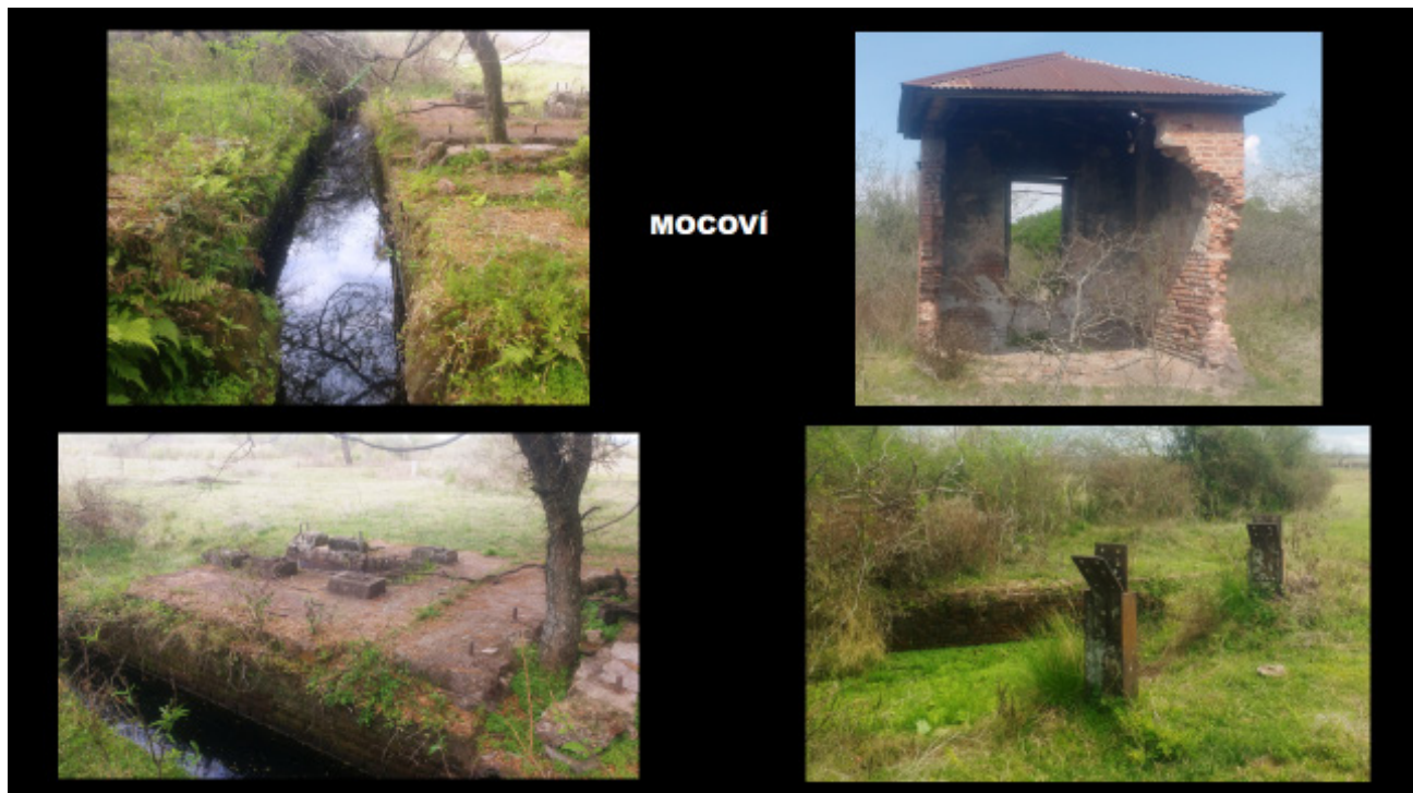
Figura 5. Fundaciones en sector sala de máquinas (Izq.) y estructuras varias (Der.).
